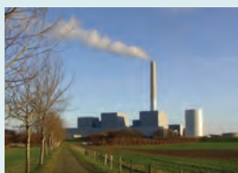
Elsam A/S, Studstrupværket, Denmark
